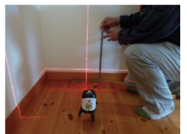
床の傾きの調査
