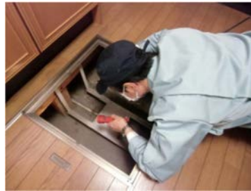
土台・床組・基礎の調査
