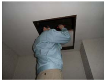
小屋組・梁の調査
