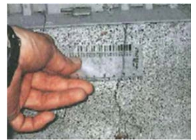
基礎ひび割れの調査
